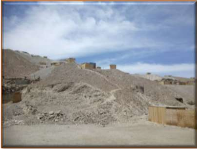
Invasión en Zona de Deslizamiento por Lluvias Intensas
