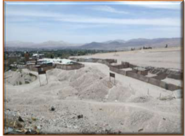
Asentamiento de Infraestructura Provisional en Zona de Deslizamiento
