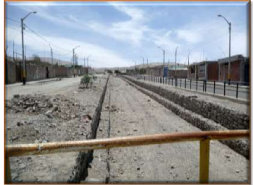
Infraestructura de Protección de Huaico en Quebrada el Cementerio
